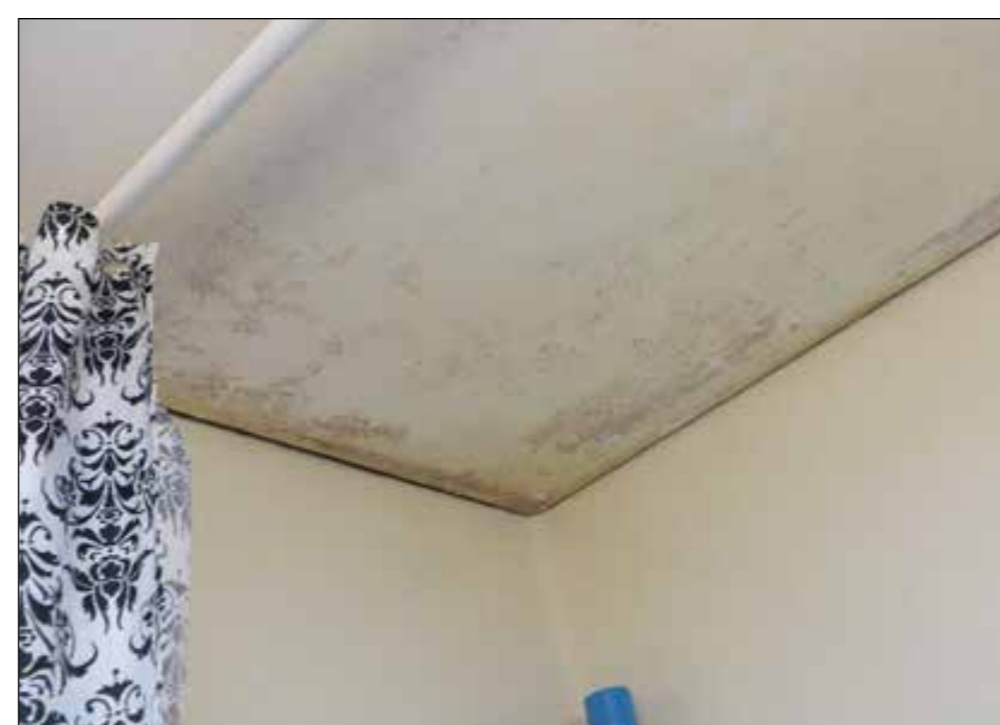
Billeder af de tekniske udfordringer med dårligt indeklima i boligerne pga. fugt, dårlig ventilatioen og utidssvarende materialer, samt generelt nedslidte installationer, der er fx. tydelig skimmel i flere lofter på badeværelser.
